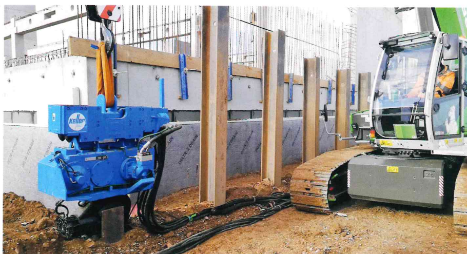
Auch für das Ziehen von Trägern mit Rüttler ist eine Sennebogen Tele-Raupe bestens geeignet.
